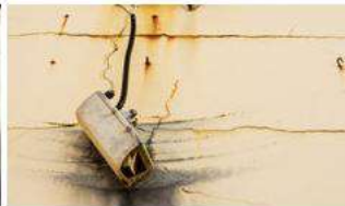
Mal funcionamiento debido a la corrosión
